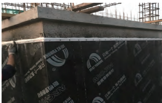
图7 压条施工
