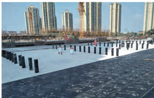
图5 卷材施工
