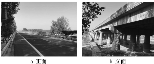
图2 佟家庄大桥整体外观
