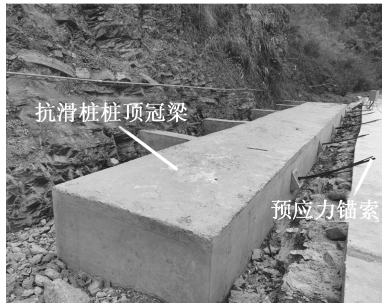
图 2 坡脚抗滑桩与预应力锚索防护体系
