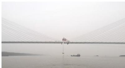
图 4 合龙段桥面吊机吊装
