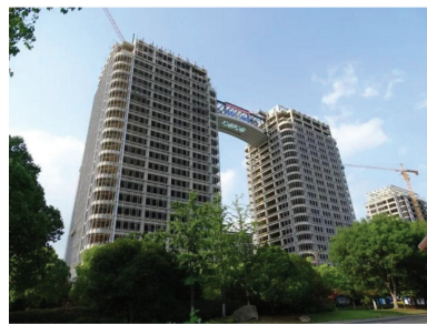
图10 钢连廊施工竣工效果
