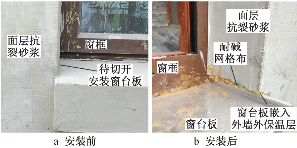
图 6 窗台板安装前后对比
