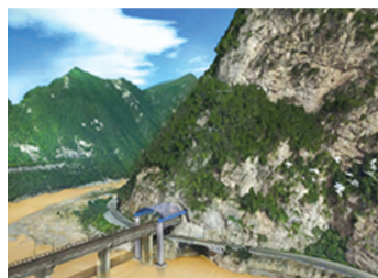
图1 病害区域地形地貌及钢棚洞竣工
