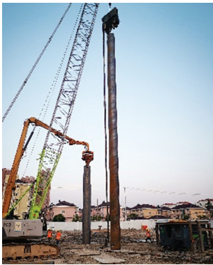
图 4 试桩打入 Fig. 4 Test pile driving
