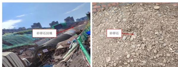
图 18 砂卵石换填施工
