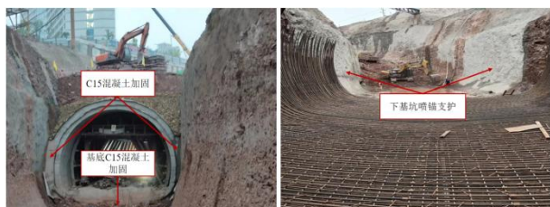
图 17 隧道基底及基坑喷锚支护和混凝土换填施工
