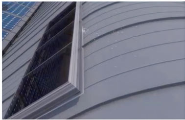
图 9 天窗泛水板收口焊接效果 Fig. 9 Welding effect of roof light flashing plate
