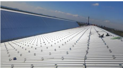
图 4 底板施工效果
