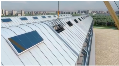
图 8 屋面天窗整体吊装 Fig. 8 Integral hoisting of roof light
