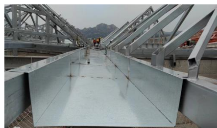
图 4 天沟系统安装
