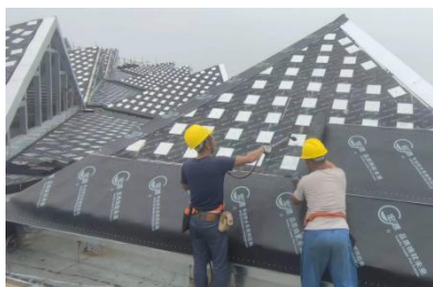
图 5 棱锥防水卷材铺设
