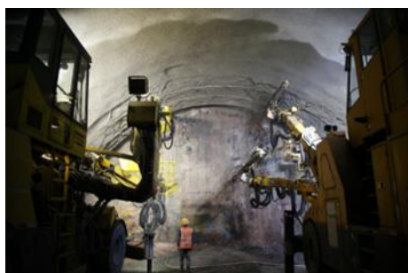
图 3 隧道掌子面双机并打模式 Fig.3 Dual machine parallel drilling mode for tunnel palm face
