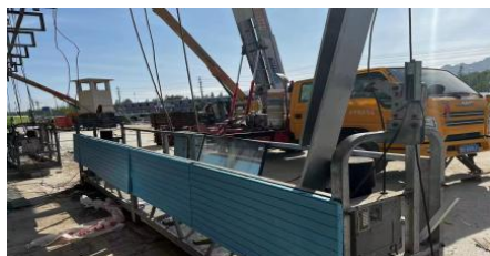
图 4 吊篮软包围处理防护
