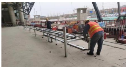
图 6 龙骨焊接成型
