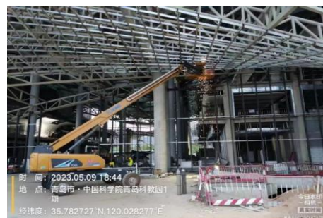
图 8 焊接施工
