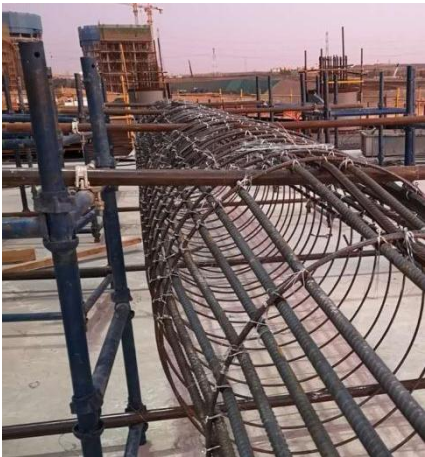
图 3 钢筋笼现场绑扎
