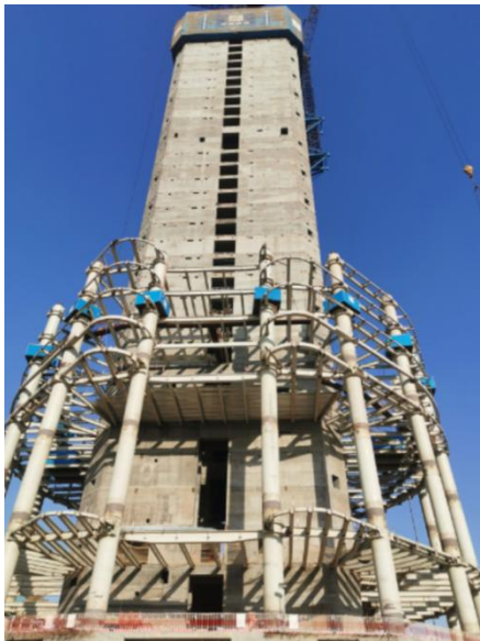
图 9 标志塔钢管柱安装
