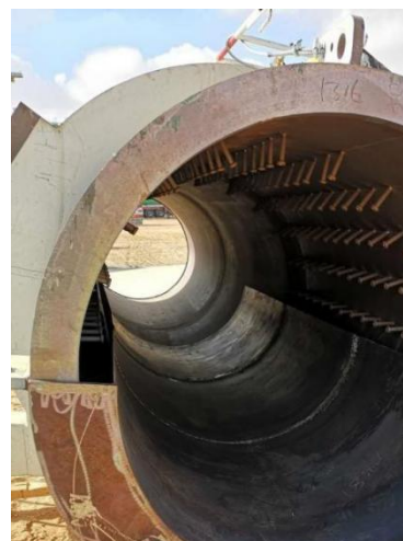
c 安装完成
