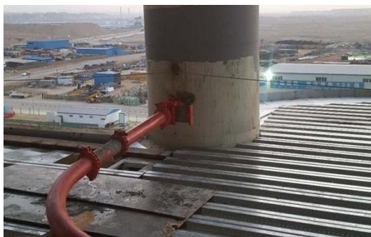
图 8 顶升管线安装
