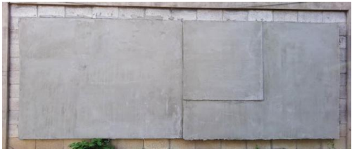
图 5 试验墙最终效果 Fig.5 The final look of the test wall
