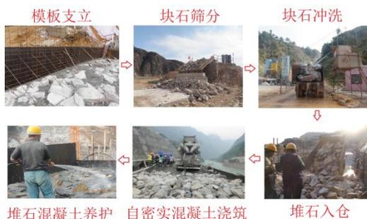
图 2 堆石混凝土坝施工工艺流程
