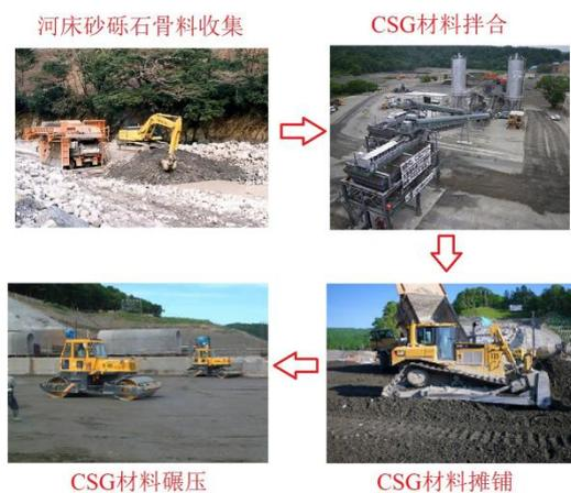
图 1 CSG 坝施工工艺流程
