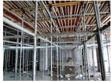
图6 盘扣式钢管支撑架顶部用木方及双钢管作为面板主次楞
