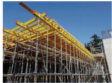
图7 支撑架上部用木工字梁做主次楞
