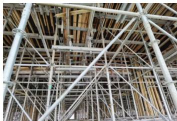
图9 使用 L150 型铝梁作为主楞的立杆大间距布置的盘扣式钢管支模架
