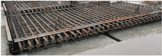
图 6 桥面板标准化模具
