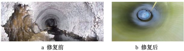
图 4 紫外光固化修复效果 Fig. 4 UV curing repair effect
