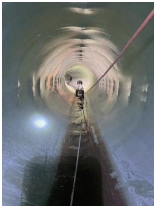
图 11 管道修复效果 Fig. 11 Pipeline repair effect
