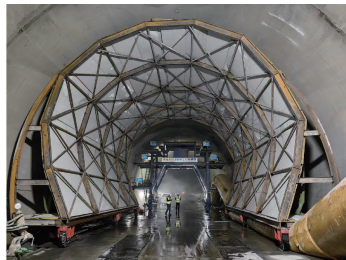
图 2 台车骨架
