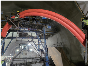
图 7 气囊安装
