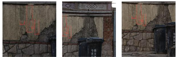
图 12 裂缝检测效果
