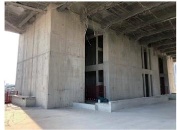
图11 模板拆除后效果
