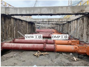
图 10 DMP 工法同 SMW 工法开挖后对比
