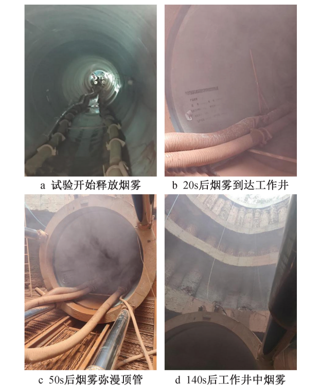
图 1 发烟试验 Fig. 1 Smoke test
