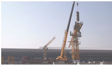
图 10 塔式起重机拆除 Fig. 10 Tower crane dismantling
