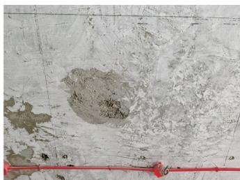
图3 混凝土孔洞及离析
