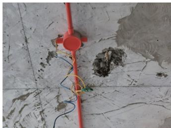
图2 混凝土麻面、离析、钢筋漏筋
