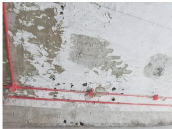
图1 混凝土裂缝及离析
