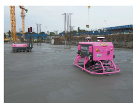
c 地面抹光机器人作业
