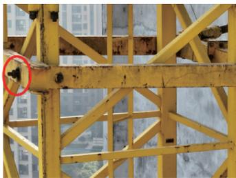
图6 附墙装置连接螺栓松动
