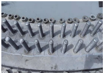
b 密封胶涂抹实际情况
