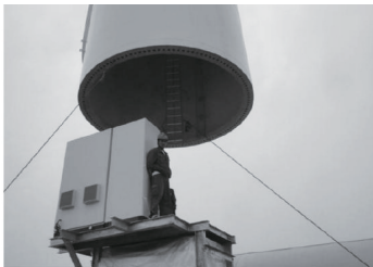
图 5 塔筒底段安装
