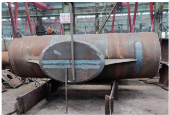
图 21 弧形弯管附件安装
