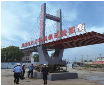
图 5 缩尺模型桥 Fig. 5 Scaled model bridge
