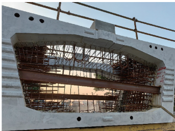
图 14 墩顶块加装临时工字钢加劲肋
