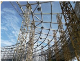
图12 郑州奥体中心体育场施工现场
