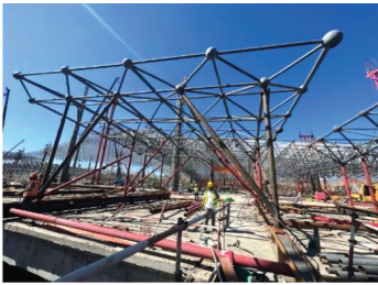
图 10 现场滑移施工
