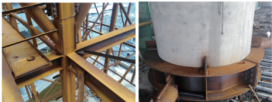
a 圆管垂直支撑-钢柱连接节点 b 系杆-钢抱箍连接节点
