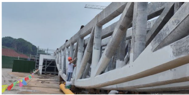
图 12 构件表面装饰施工
