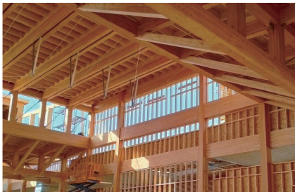
图 9 施工完成效果
