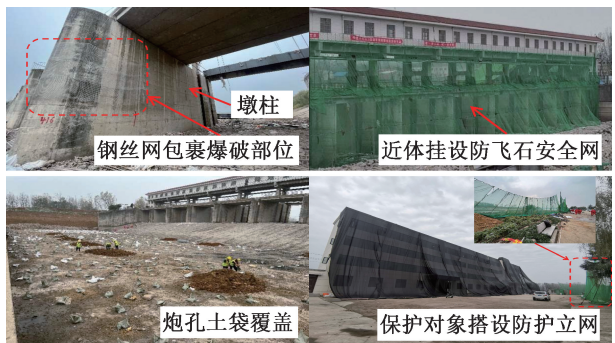
图 3 爆破防护措施 Fig. 3 Blasting protective measures
