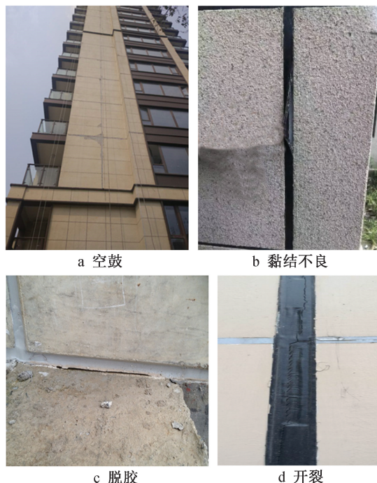
图 3 装配式混凝土建筑外墙接缝密封缺陷
