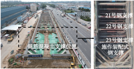
图 8 装配式钢支撑和钢筋混凝土支撑联合支护
