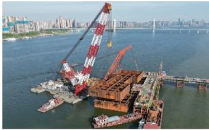
图 9 围堰与钢护筒水上接高作业
