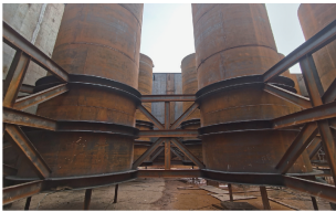
图 8 钢护筒与围堰焊接
