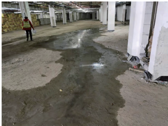
图 2 地下 2 层墙根上浮破坏 Fig. 2 Uplift damage at the wall base of B2 floor
