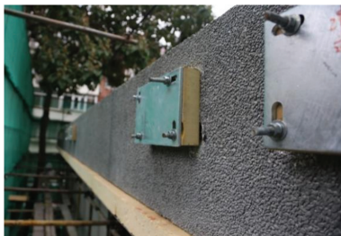
图4 光伏幕墙牛腿无热桥做法
