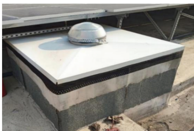
图5 光导管做法
