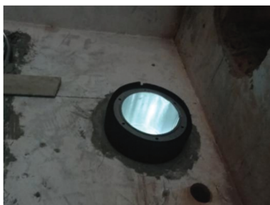
图6 风管穿外墙无热桥做法
