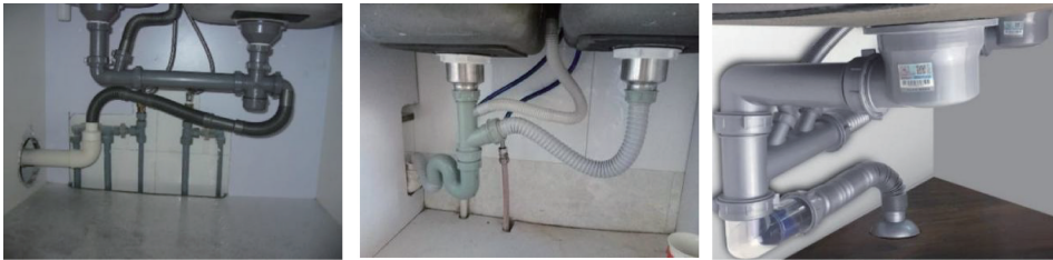
图7 目前住宅厨房常用的水槽下多头三通、简化水封安装方式
