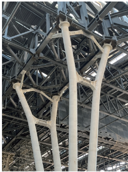
图 5 树杈柱与屋盖对接
