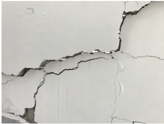
图 15 填充墙沉降开裂
