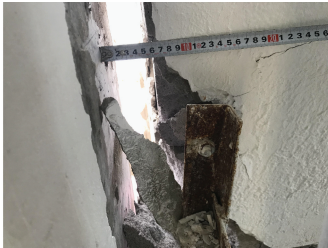
图 14 填充墙与框架柱脱开
