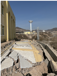
图 8 东侧围墙倒塌 Fig. 8 Collapse of east side wall
