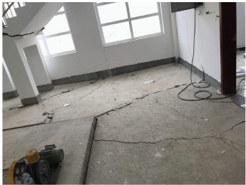
图 11 楼梯平台处拉裂 Fig. 11 Tensile cracking at stair platform
