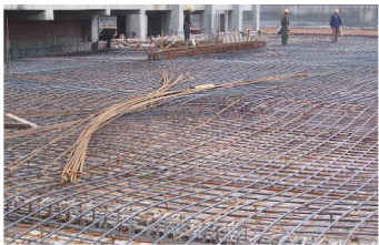
图 10 双向板面预应力筋铺设
