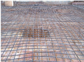
图 11 柱顶区域预应力筋铺设
