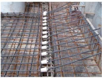
图 12 剪力墙边缘预应力筋张拉端
