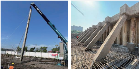
图1 DPS斜桩撑施工及完成实景
