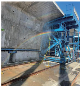
图3 自动喷淋养护系统 Fig. 3 Automatic spraying maintenance system
