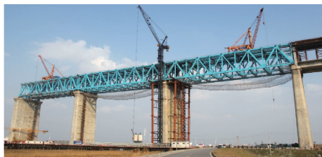
图 3 桥面结构安装前钢桁梁姿态
